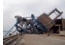
損傷を受けた岸壁クレーン
