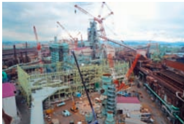
建設中の新第2高炉
