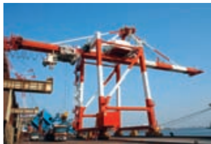
損傷した岸壁クレーンの代替として 和歌山製鉄所から移設されたクレーン
