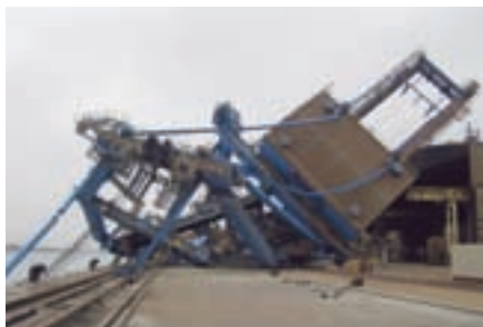
津波により漂流した船によって損傷を受けた 岸壁クレーン
