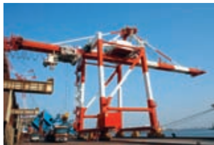
損傷した岸壁クレーンの代替として 和歌山製鉄所から移設されたクレーン
