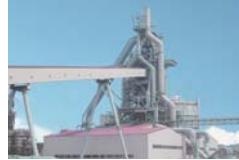
和歌山製鉄所 新第1高炉
